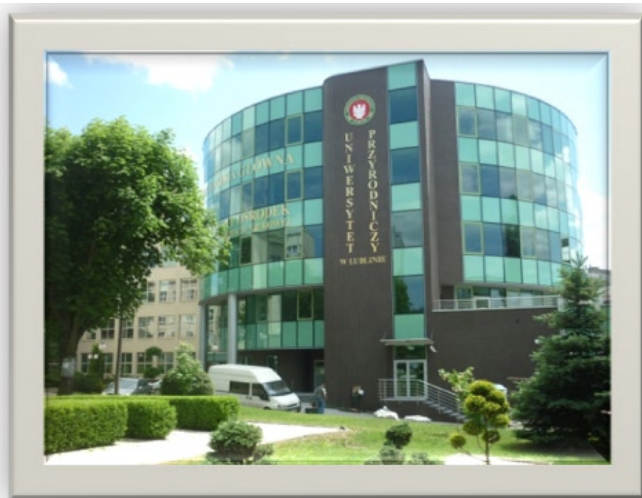
Widok budynku biblioteki od strony północnej
