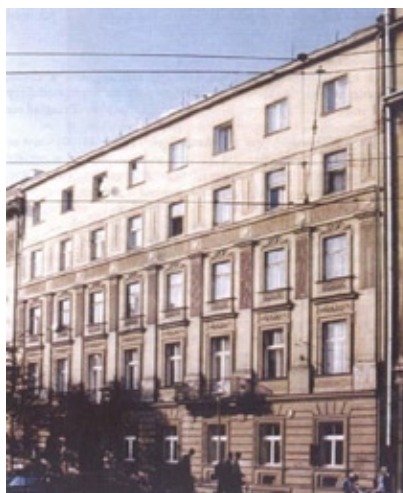
Kamienica (pałac Popielów) ul. Basztowej 3
