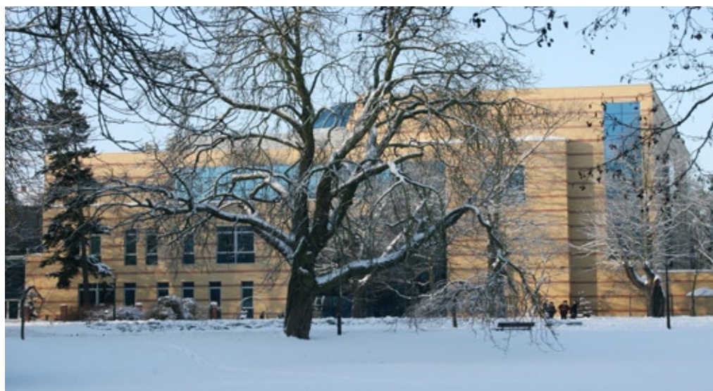
Budynek WiMBP od strony Parku Wiosny Ludów
