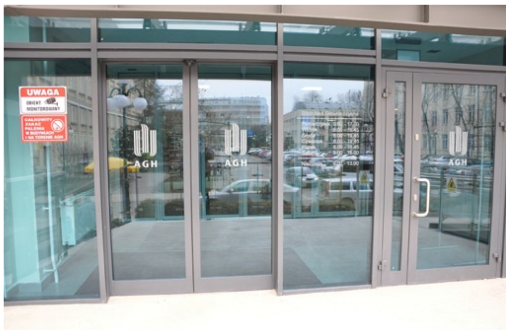
Drzwi frontowe po modernizacji elewacji południowej
