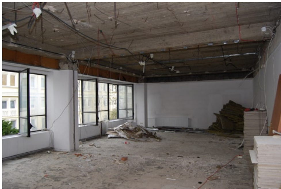
Modernizacja starej części budynku
