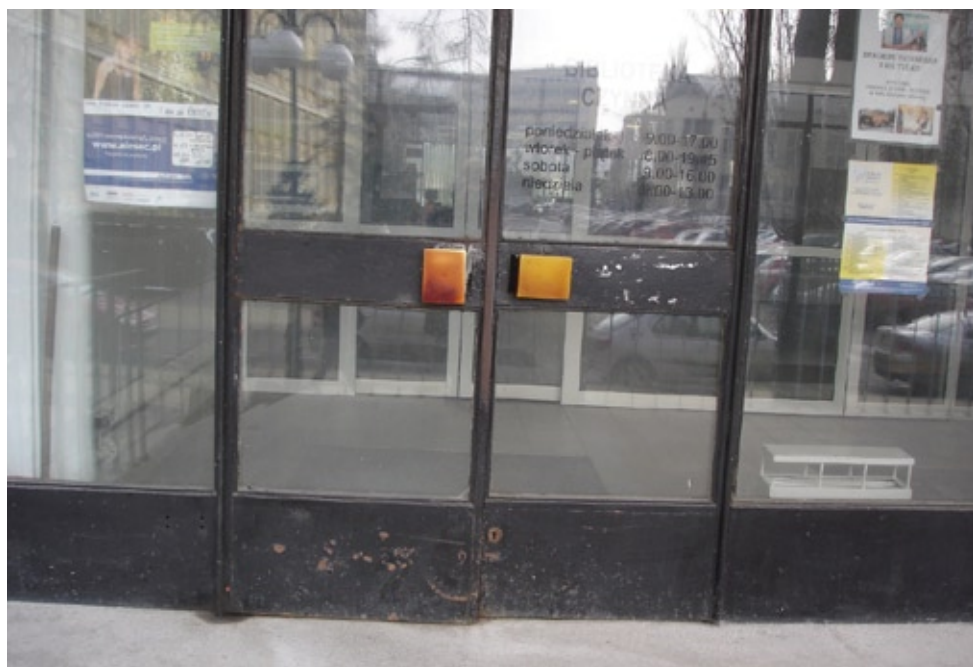
Drzwi frontowe przed modernizacją elewacji południowej
