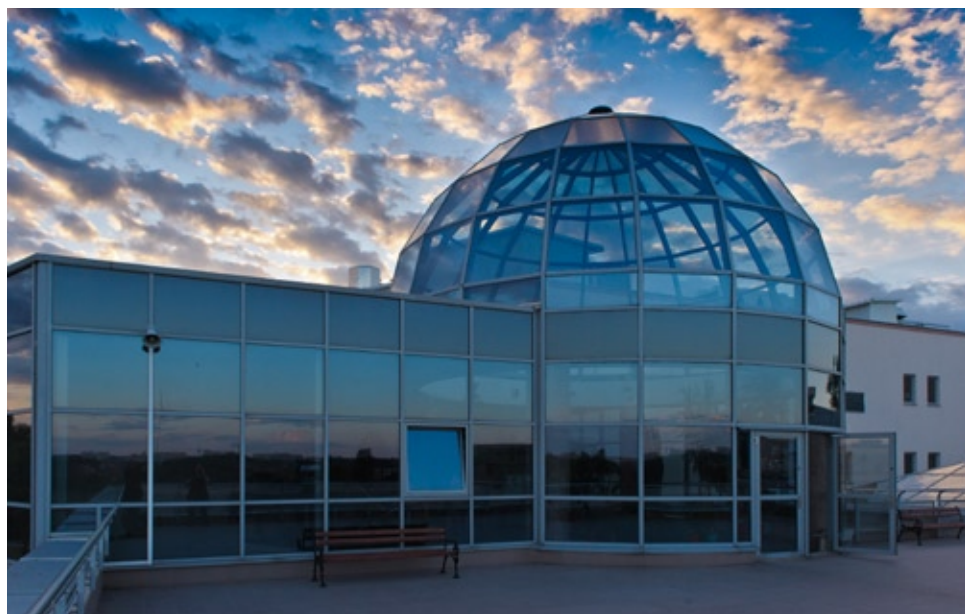
Taras przy ogrodzie zimowym - przestrzeń wypoczynkowa
